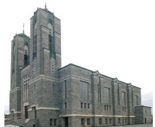
L'église Sainte-Marguerite-Marie (Magog), érigée en 1949-1950 selon les plans des architectes Albert et Joseph-Aimé Poulin
