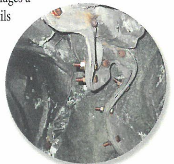
À l'intérieur de la figure La Charité, qui fait partie du monument de M sr Bourget, les boulons d'acier corrodés (en haut) sont remplacés par un nouveau boulonnage en bronze silicium.
