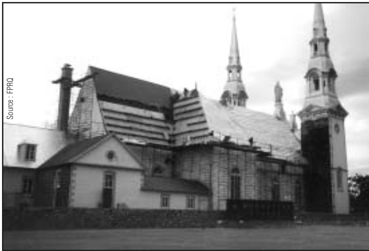
Église Saint-Louis, Lotbinière. Travaux de réfection de la toiture.
