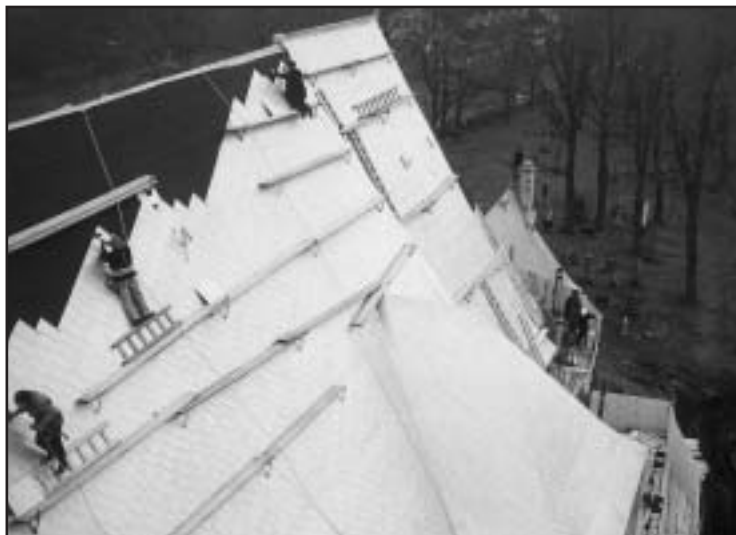
Église Sainte-Famille, Cap Santé. Travaux sur le toit.
