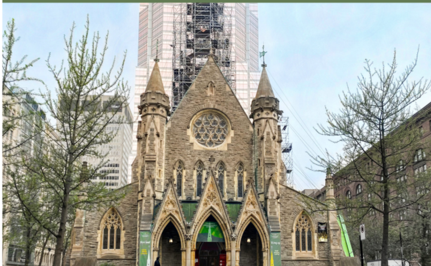
La cathédrale Christ Church, en chantier de restauration pour son clocher.
