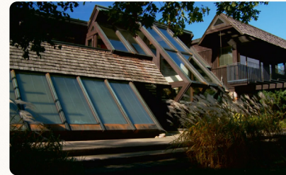
Résidence solaire Corbeil ou Silbert (1984-1988), Île Cadieux
