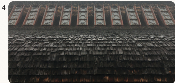
1. Abside et toiture en arc infléchi.
